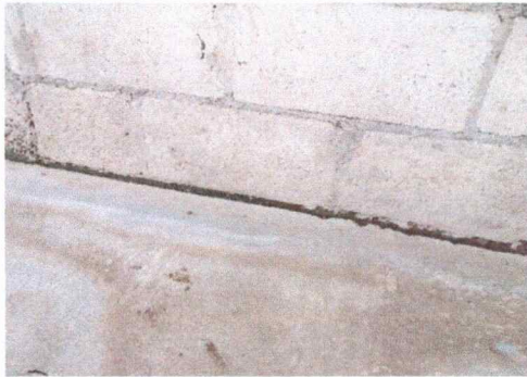
Foto1: MODULO No. 5, REPARACION DE PISO DE TORTA DE CEMENTO
