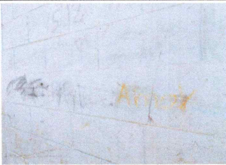
Foto 5: MODULOS 1, 2, 3, 4 Y 5. PINTURA EN MURO INTERIORES Y EXTERIORES ( DOS MANOS)
