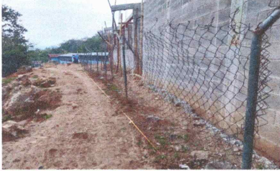
Foto 1: SUMINISTRO Y CONSTRUCCION DE MURO PERIMETRAL
