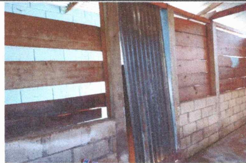
Foto 4: MODULO No. 5 SUMINISTRO DE PUERTA DE METAL
