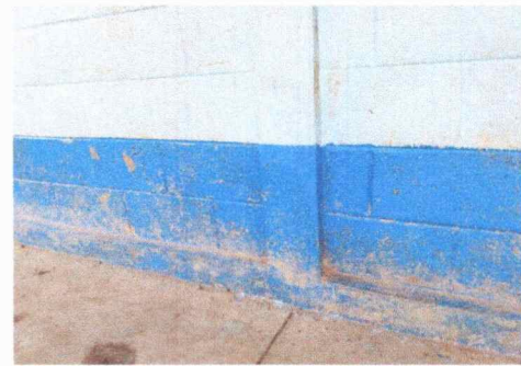
Foto 4: MODULOS 1, 2, 3, 4 Y 5. PINTURA EN MURO INTERIORES Y EXTERIORES ( DOS MANOS)
