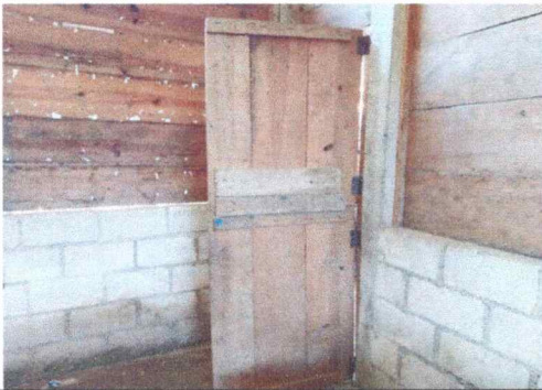
Foto 3: MODULO No. 5, SUSTITUCION DE PUERTA DE MADERA POR PUERTA DE METAL
