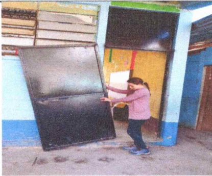
Foto 3: MODULO No. 4, SUSTITUCION DE PUERTA D METAL
